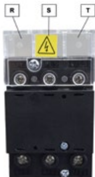
Imagem 1 - ligação dos fios da rede na chave seccionadora do painel
