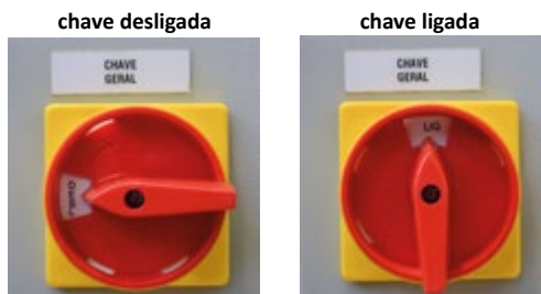
Imagem 3 – girar a chave seccionadora para a posição liga
