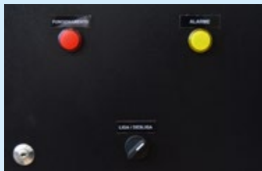
Figura 8 - Chave seletora na posição desliga
